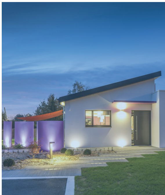
Bepos Effinergie 2013 | La Ferrière (85) | Constructeur : La Bocaine
